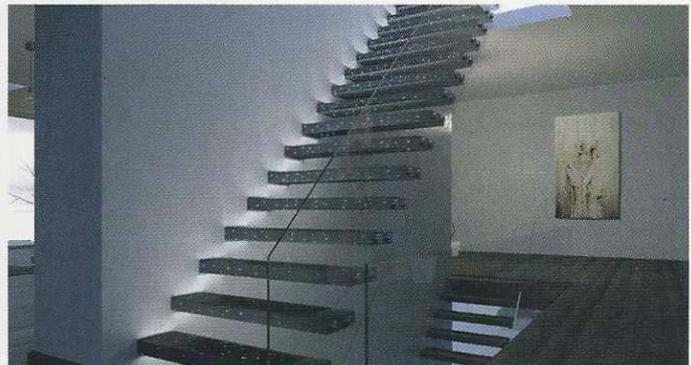
▲ Lichtfaserbeton kann als Treppen-, Boden- oder Wandelement genutzt werden.
